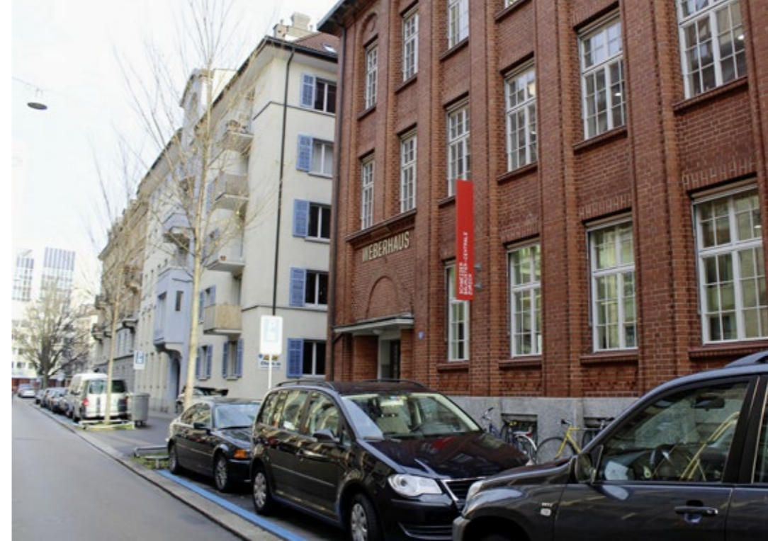
Die Schweizer Baumuster-Centrale ist seit 2010 im Zürcher Weberhaus untergebracht.
