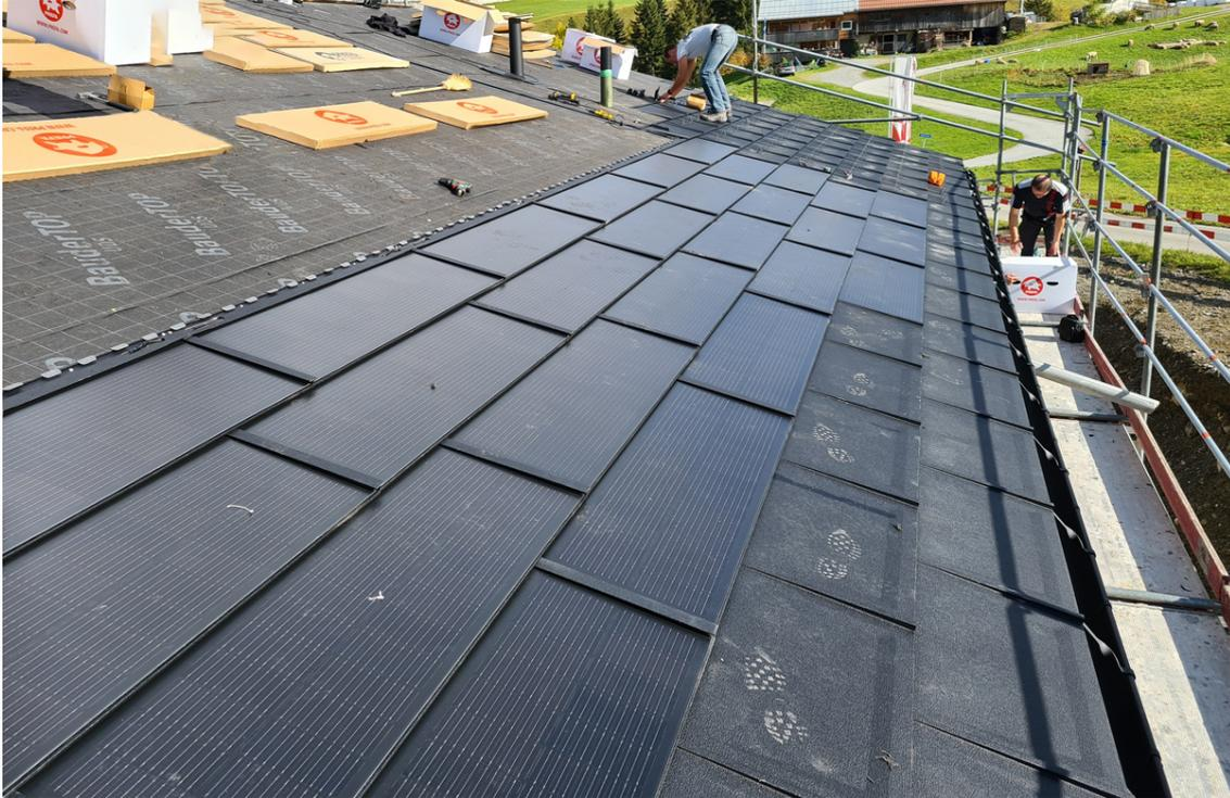
Dachaufbau aus Aluminium Dachplatten mit und ohne integrierten PV Elementen Bild: PREFA
