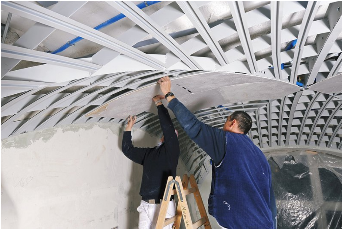
Seit 2013: Formteilproduktion in Oberbüren/SG; mit Biege- und Falttechnik bis hin zu Kuppeln und Deckensegeln (Bild: Montage im Landesmuseum Zürich).
