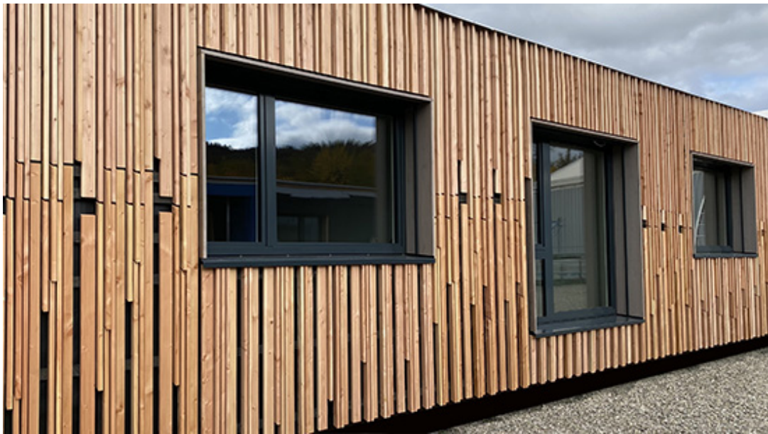
Modulares Bürogebäude verkleidet mit CODEFA Elementen, Stein AG, 2020 Bild: ERNE AG Holzbau
