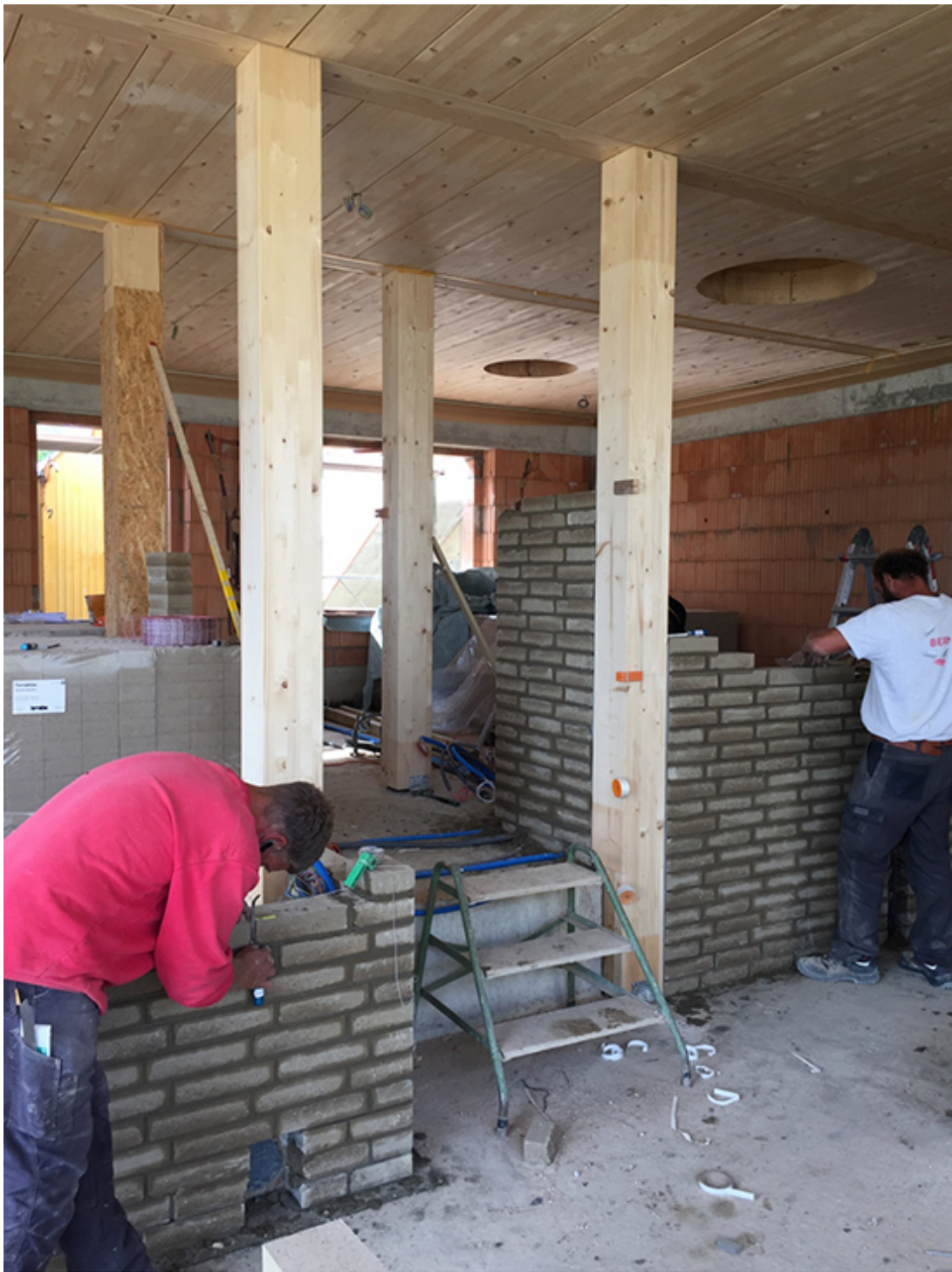
Baustelle Bellerive, Jomini Zimmermann Architekten, 2020
