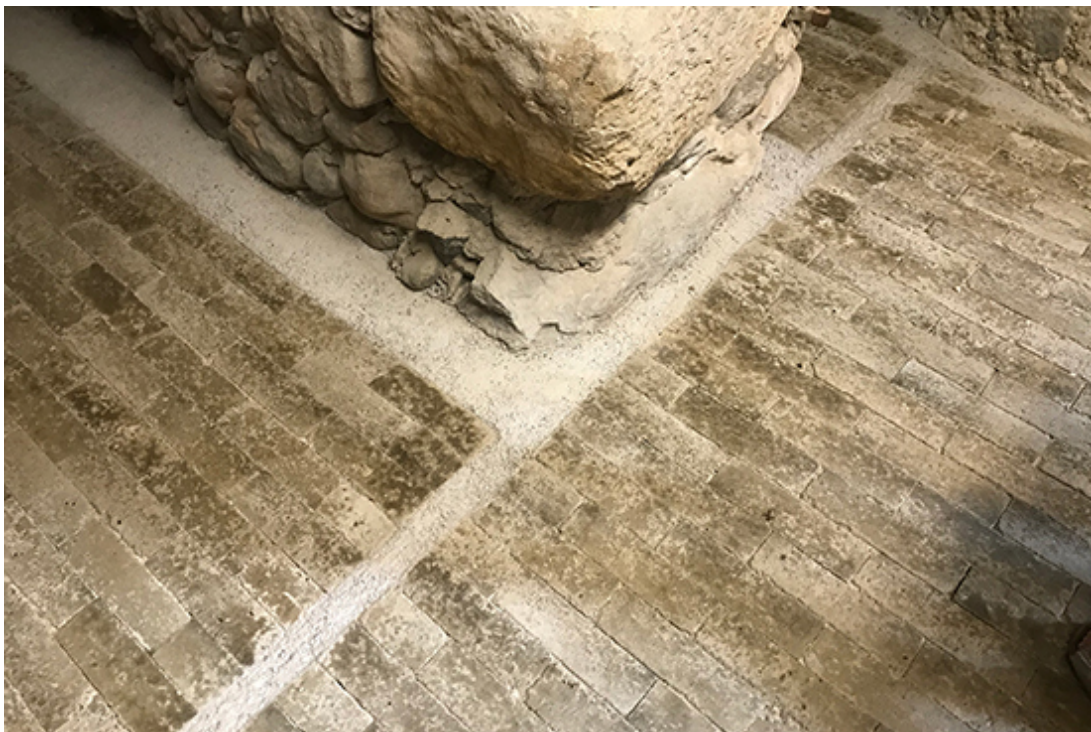
Lehmsteine für den Keller des Schlosses Compesières
