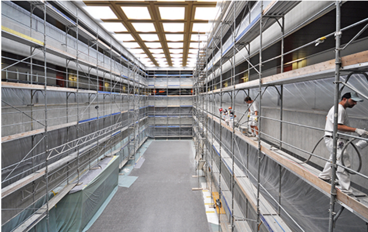
Instandsetzung der KV-Business School in Zürich, S+M Architekten AG
