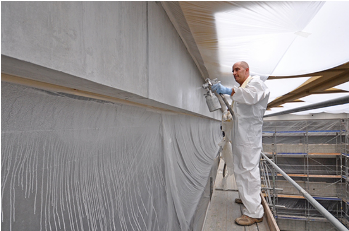
Instandsetzung der KV-Business School in Zürich, S+M Architekten AG
