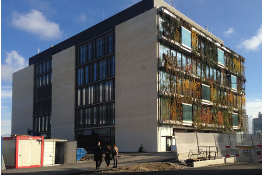
Novartis Camaps in Basel, das neue Laborgebäude «Virchow 16»
