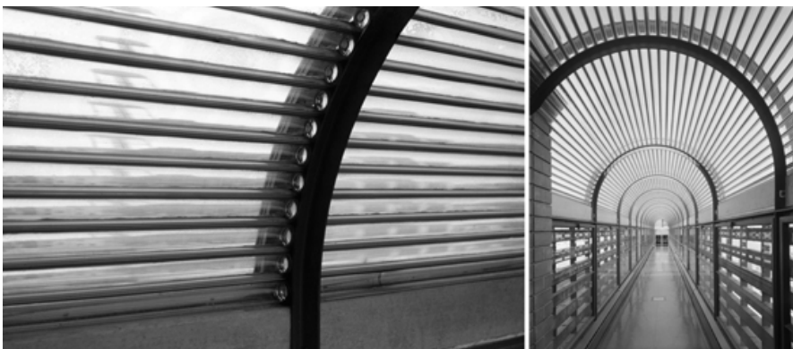
Verbindungsgang zum Turm nach der Renovation, Frank Lloyd Wright Architekt
