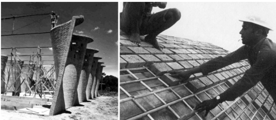
Bauarbeiten an der «Cristo Obrero»-Kirche in Estación Atlántida des uruguayischen Architekten Eladio Dieste.
