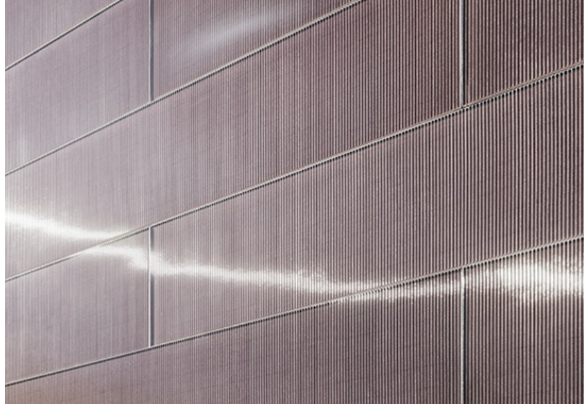
Haus Solaris Fassadenkraftwerk, huggenbergerfries Architekten Zürich, 2011–2017
