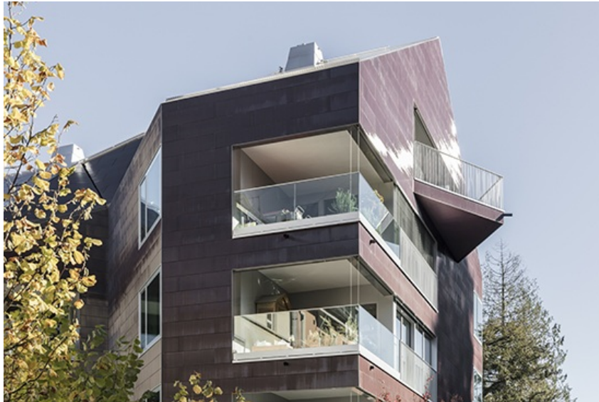
Haus Solaris Fassadenkraftwerk, huggenbergerfries Architekten Zürich, 2011–2017
