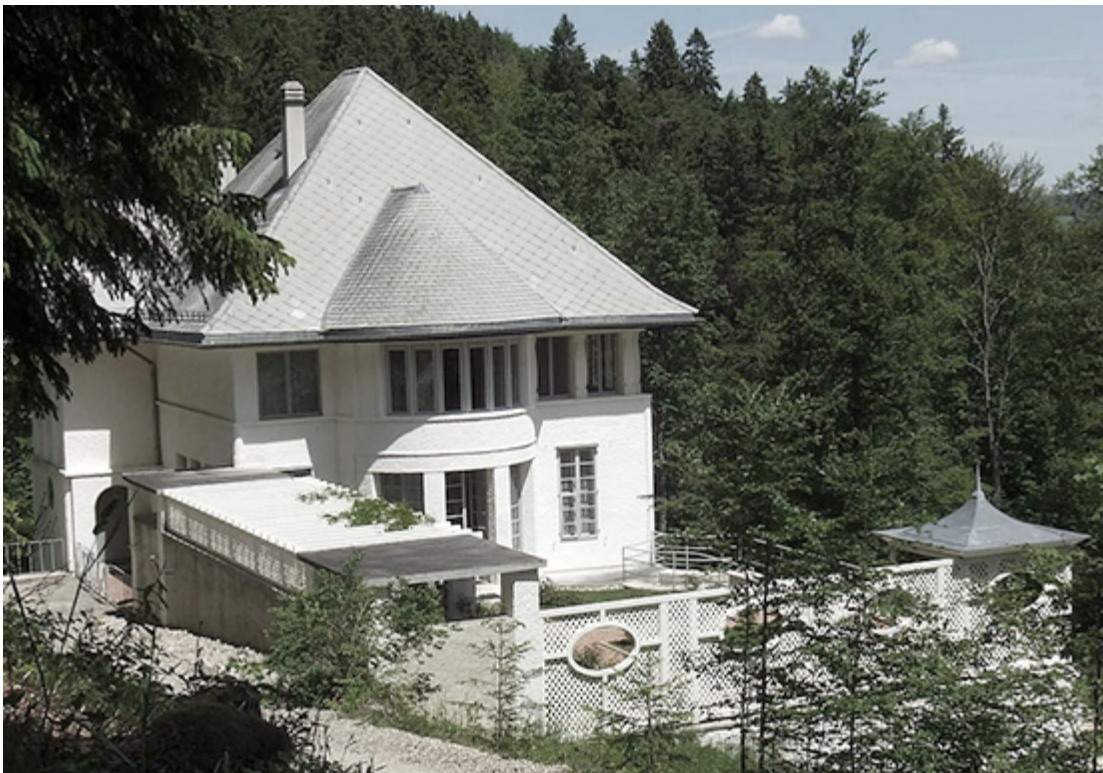
Eternit Dach, Maison Blanche, La Chaux-de-Fonds von Le Corbusier 1911-1912
