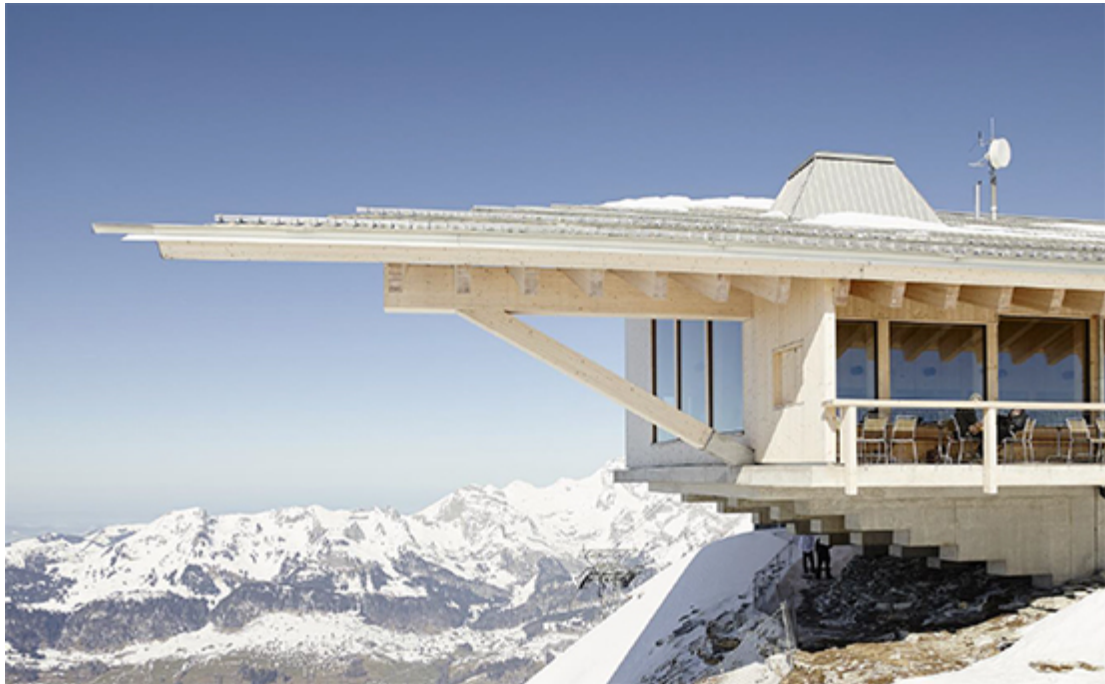
Chäserrugg: Architekt Herzog & de Meuron, Ingenieur Pirmin Jung, ARGE Blumer-Lehmann AG Holzbau
