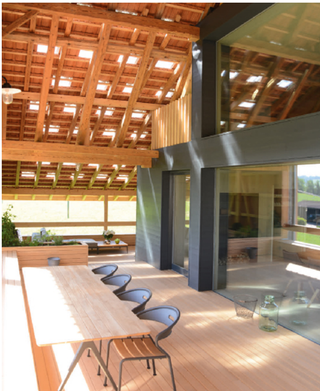
Umbau und Einbau Scheune in Wängi, Zech Architektur, Bild©: Isenring Holzbau AG
