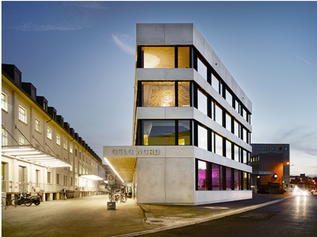
Oslo Nord, Dreispitz-Areal, Münchenstein BL ffbk Architekten AG, 2012-2015 Foto: Johannes Marburg
