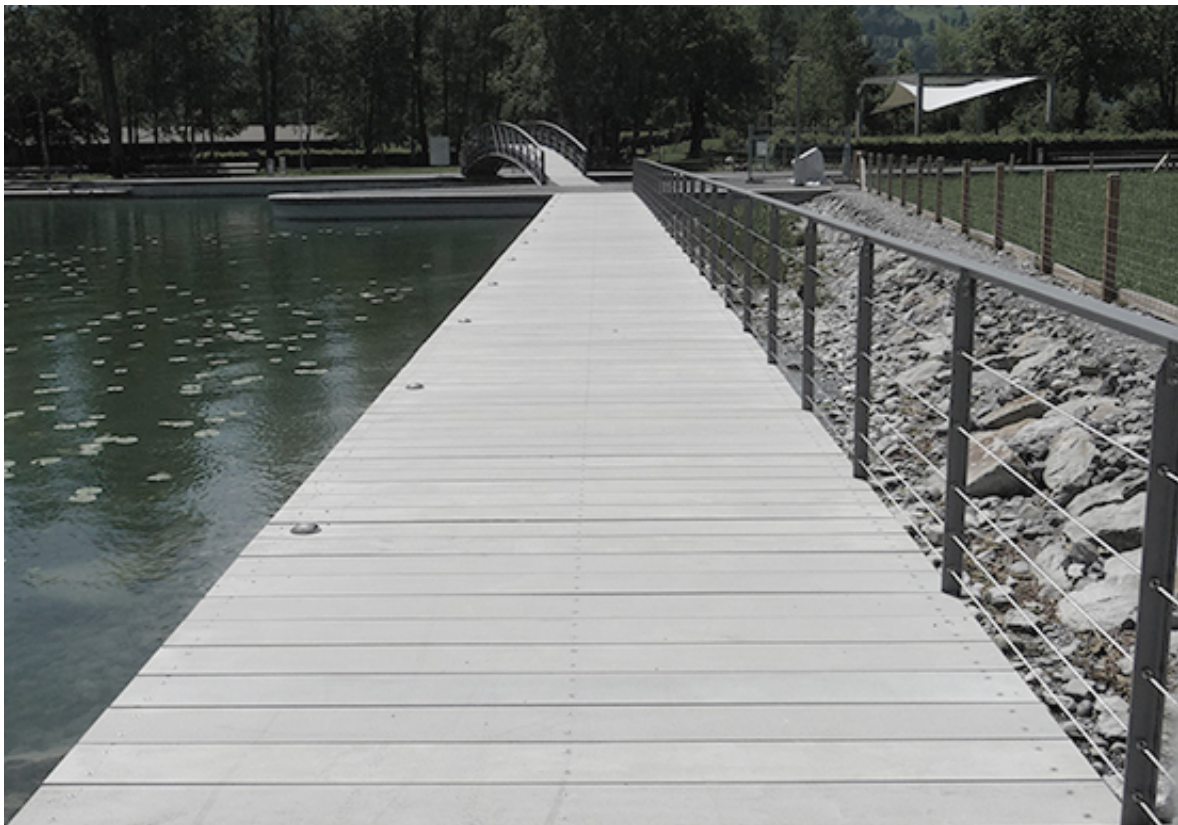
Brücke Unterägeri, Instandsetzung mit CPC-Betonplatten
