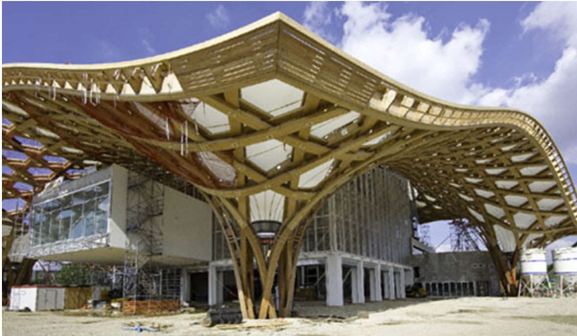
Shigeru Ban, Centre Pompidou-Metz 2010, Brettschichtträger
