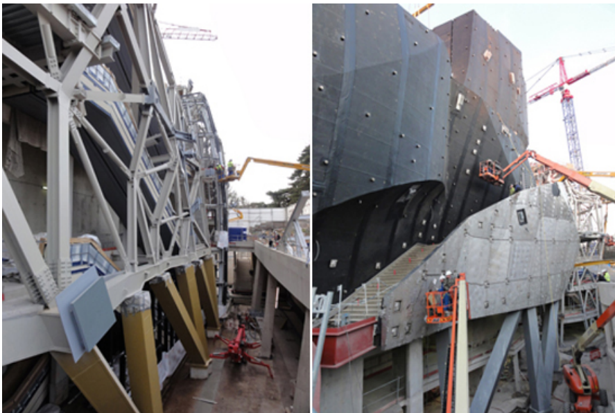
Baufortschritt FLV. Bilder: Gehry Technologies Paris
