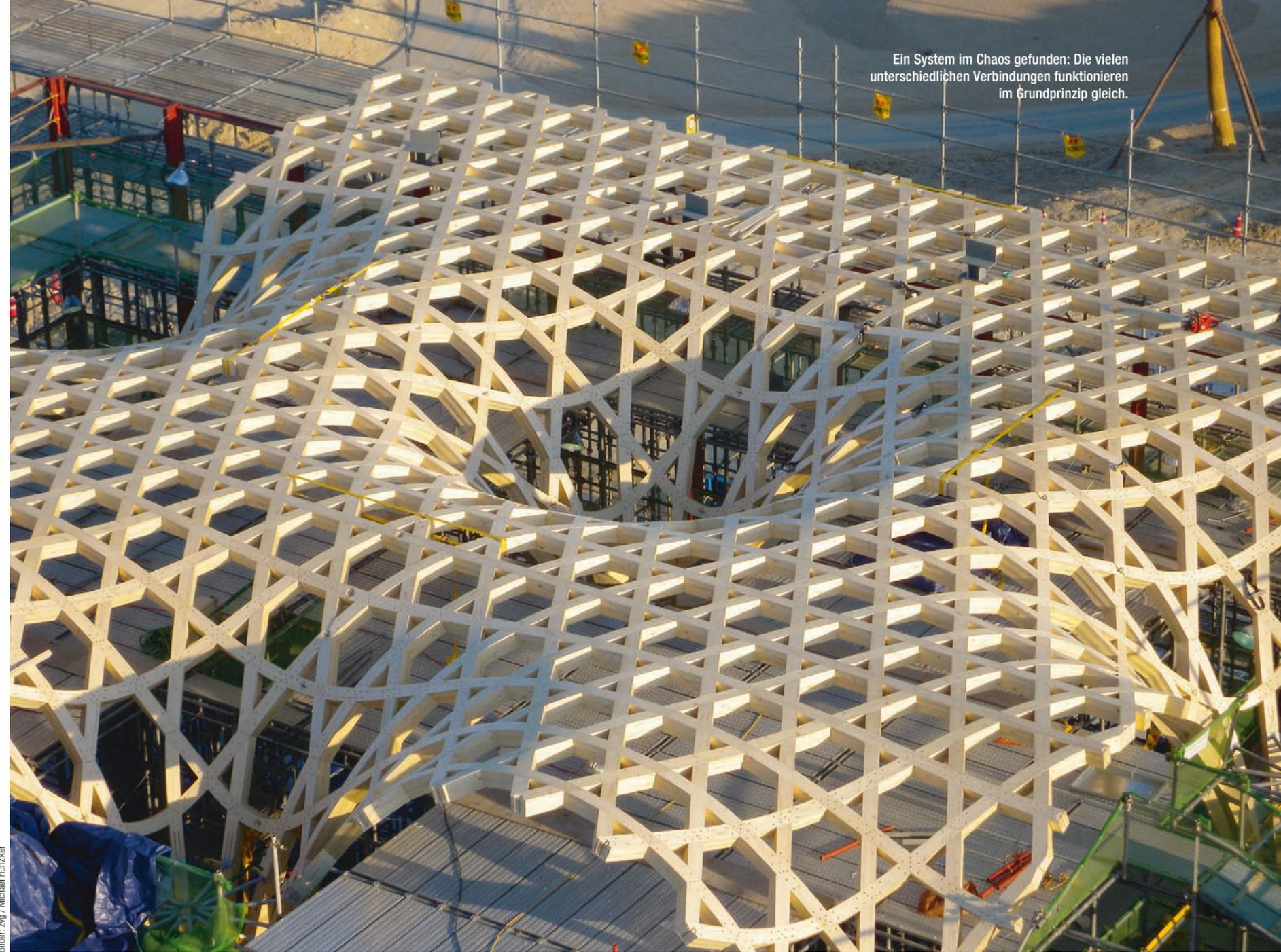
Ein System im Chaos gefunden: Die vielen unterschiedlichen Verbindungen funktionieren im Grundprinzip gleich.
